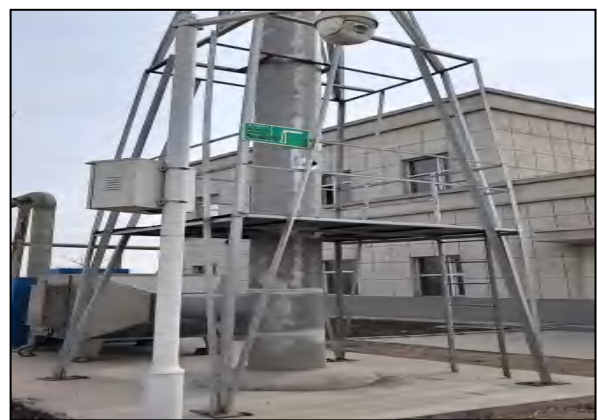
扩建项目水解酸化池及预处理车间除臭设施及排气筒
