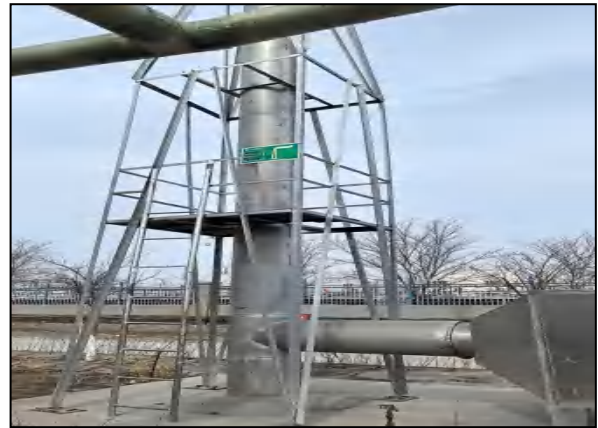
扩建项目水解酸化池及预处理车间除臭设施及排气筒
