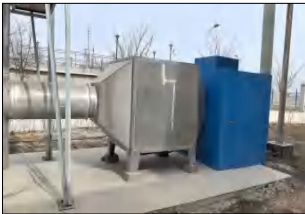
扩建项目水解酸化池及预处理车间除臭设施及排气筒
