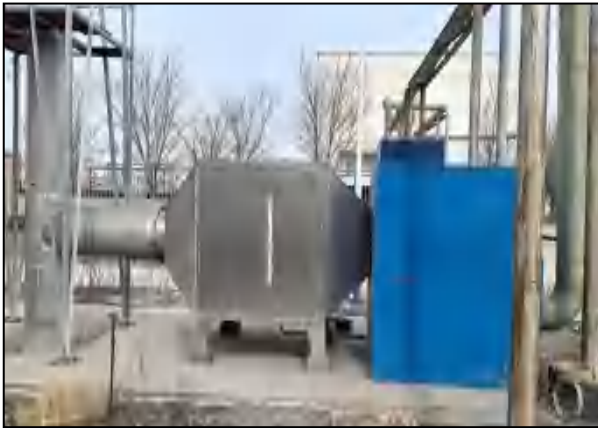
扩建项目水解酸化池及预处理车间除臭设施及排气筒
