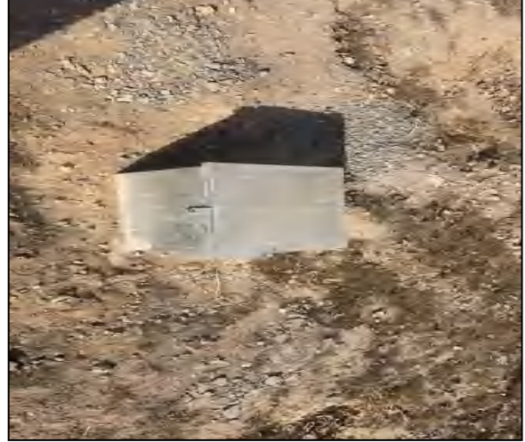
厂区南侧地下水监测井
